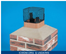
Install a chimney cap
